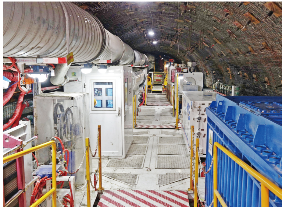
鲁西矿业李楼煤业TBM作业线。
