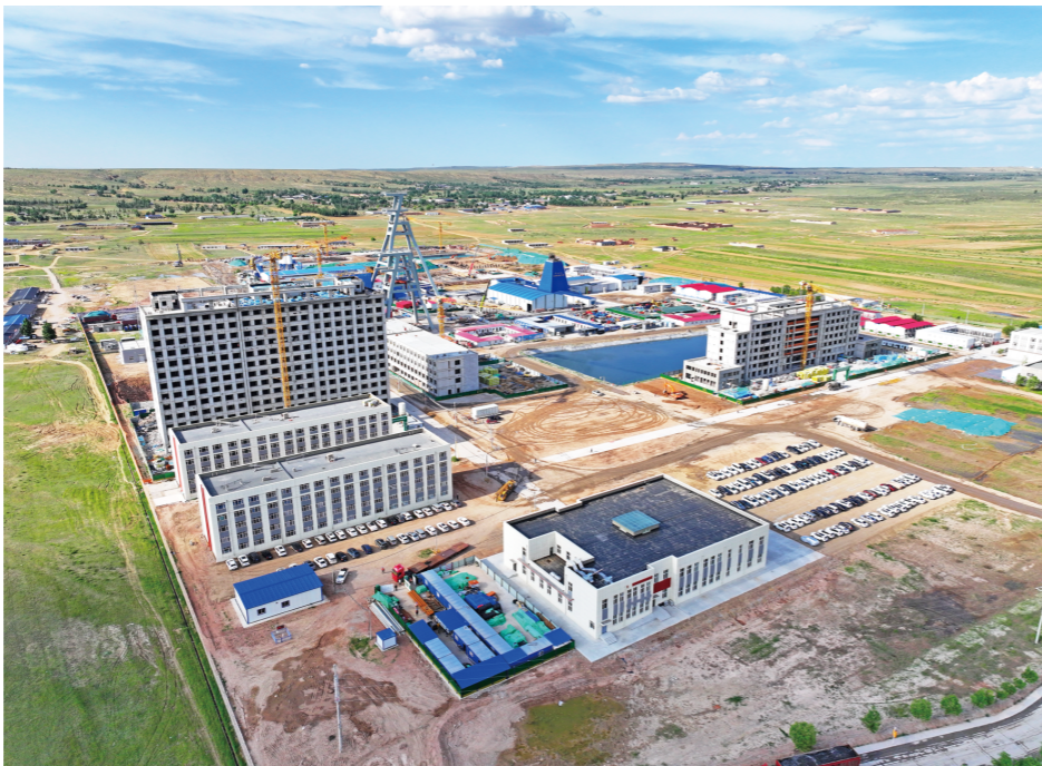
西北矿业油房壕煤矿正在建设的地上工程。
