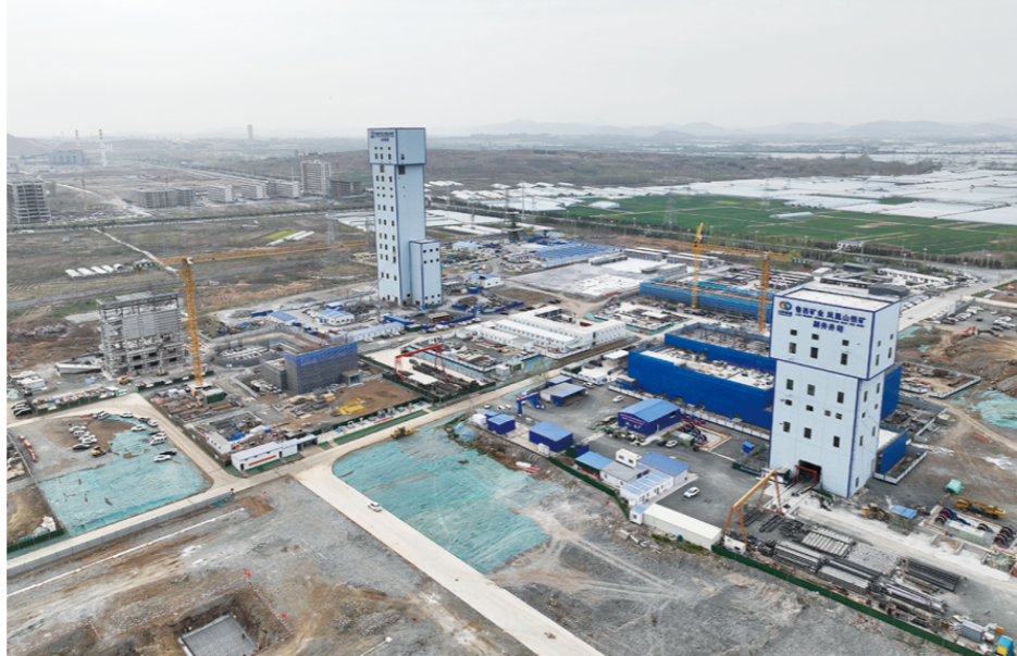
建设中的鲁西矿业凤凰山铁矿。
