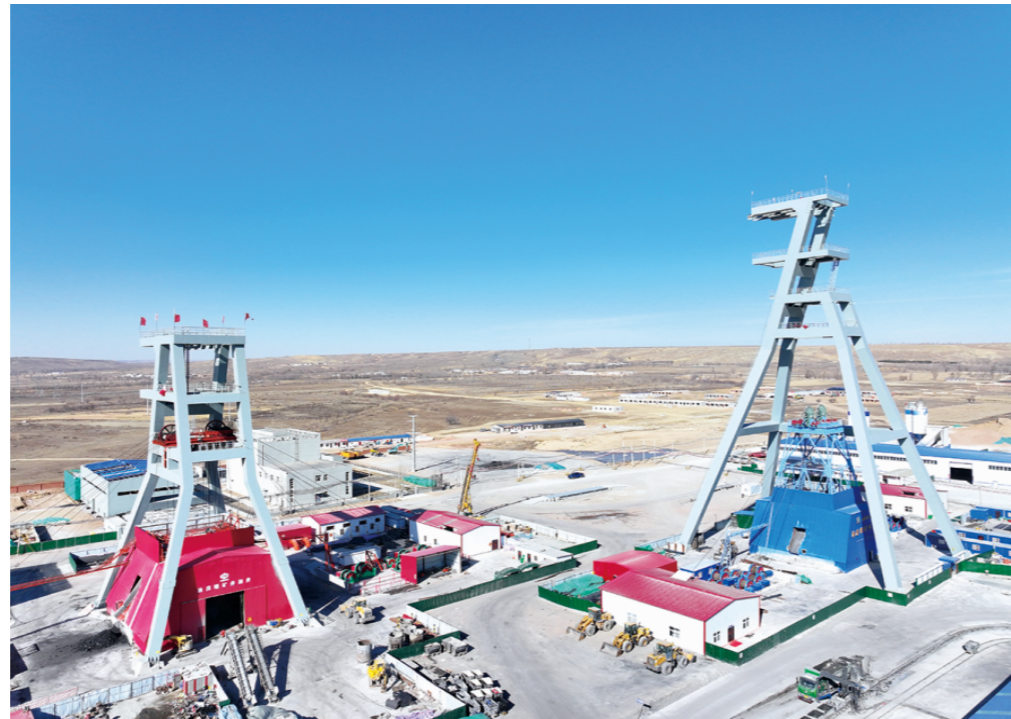
西北矿业油房壕煤矿建设现场。
