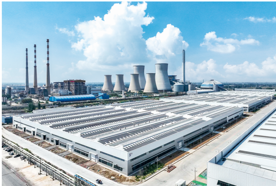
加快建设中的兖矿能源智慧制造园区。
