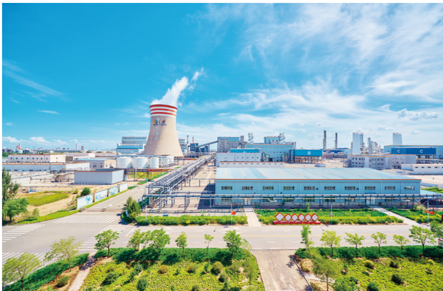
兖矿能源荣信化工生产装置区。
