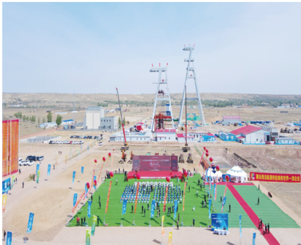
西北矿业油房壕煤矿及选煤厂项目开工仪式。
