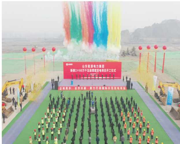
电力集团新泰2×60万千瓦级燃煤发电项目开工仪式。
