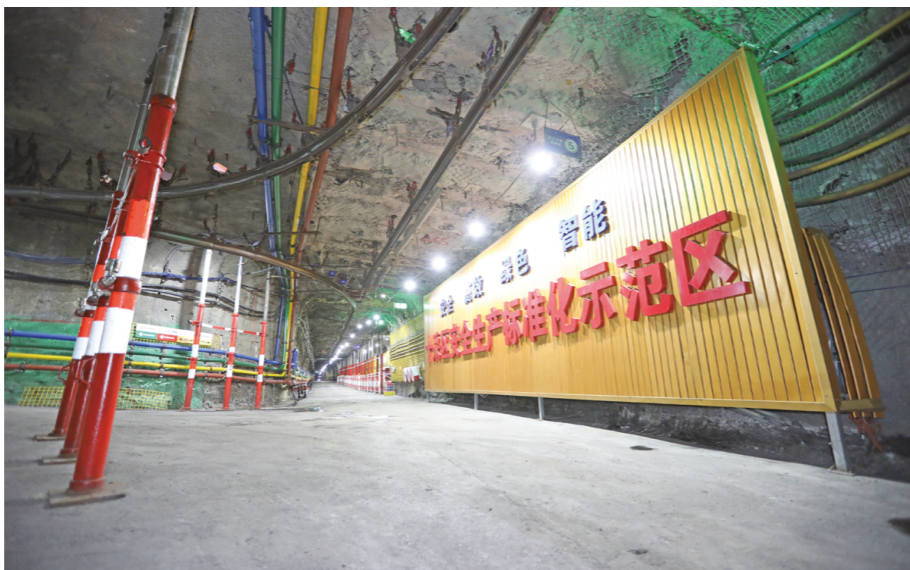
兖矿能源兴隆庄煤矿十采区安全生产标准化示范区。
