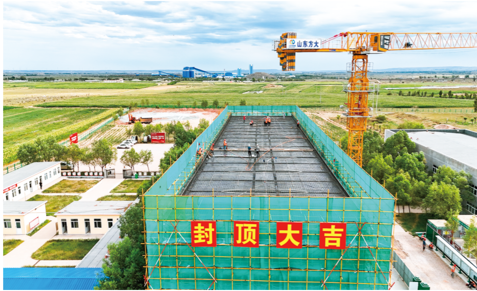
西北矿业油房壕煤矿救护队综合楼主体结构完成封顶。
