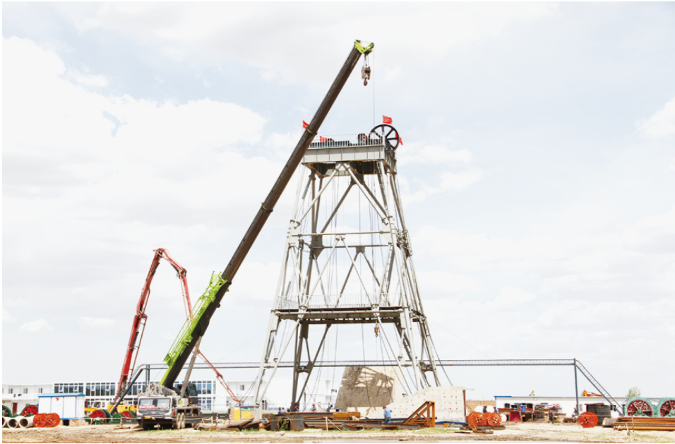
西北矿业油房壕煤矿风井正在进行绞车安装。
